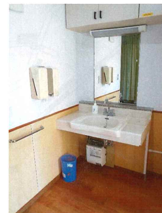
居室洗面台 （写真は多床室の洗面台）
