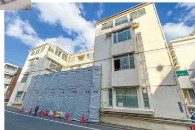
解体準備が進む 外来棟西館の西側
